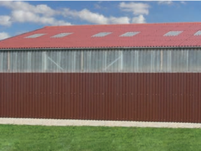
Dach Wellfaserzement, Lichtplatten, Lichtband „naturtransparent“, Trapezblech
