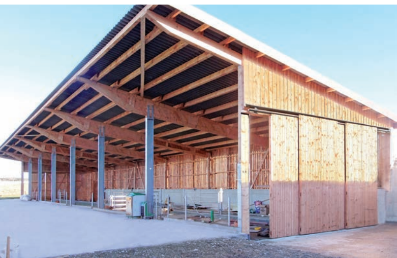
Typ AK 13, z. B. mit Kraggiebel und Schiebetoranlage im Giebel
