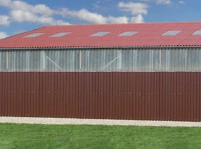
Dach Wellfaserzement, Lichtplatten, Lichtband „naturtransparent“, Trapezblech
