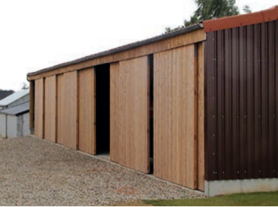
Reihentoranlage aus N+F Holzschalung, Wand Trapezblech
