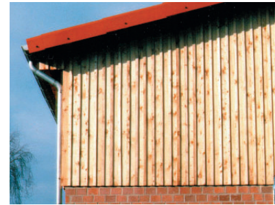
Holzdeckelschalung über baus. Teilmauerwerk
