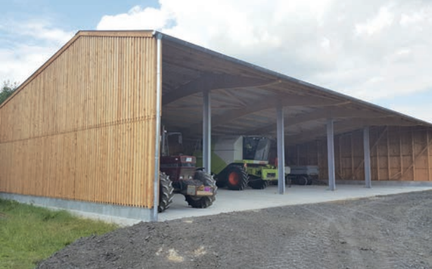
z. B. 5 Felder in Holzdeckelschalung als Wandverkleidung
