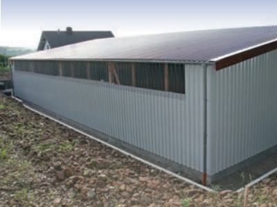
Dach und Wand Trapezblech, Lichtband „glashell“, Dachüberstand und Regenrinne
