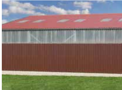
Dach Wellfaserzement, Lichtplatten, Lichtband „naturtransparent“, Trapezblech
