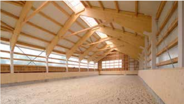
Innenansicht Reithalle Typ RBs
