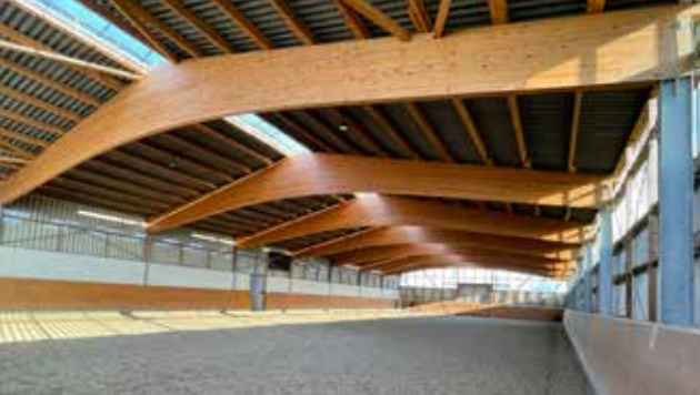
Innenansicht Reithalle Typ LB
